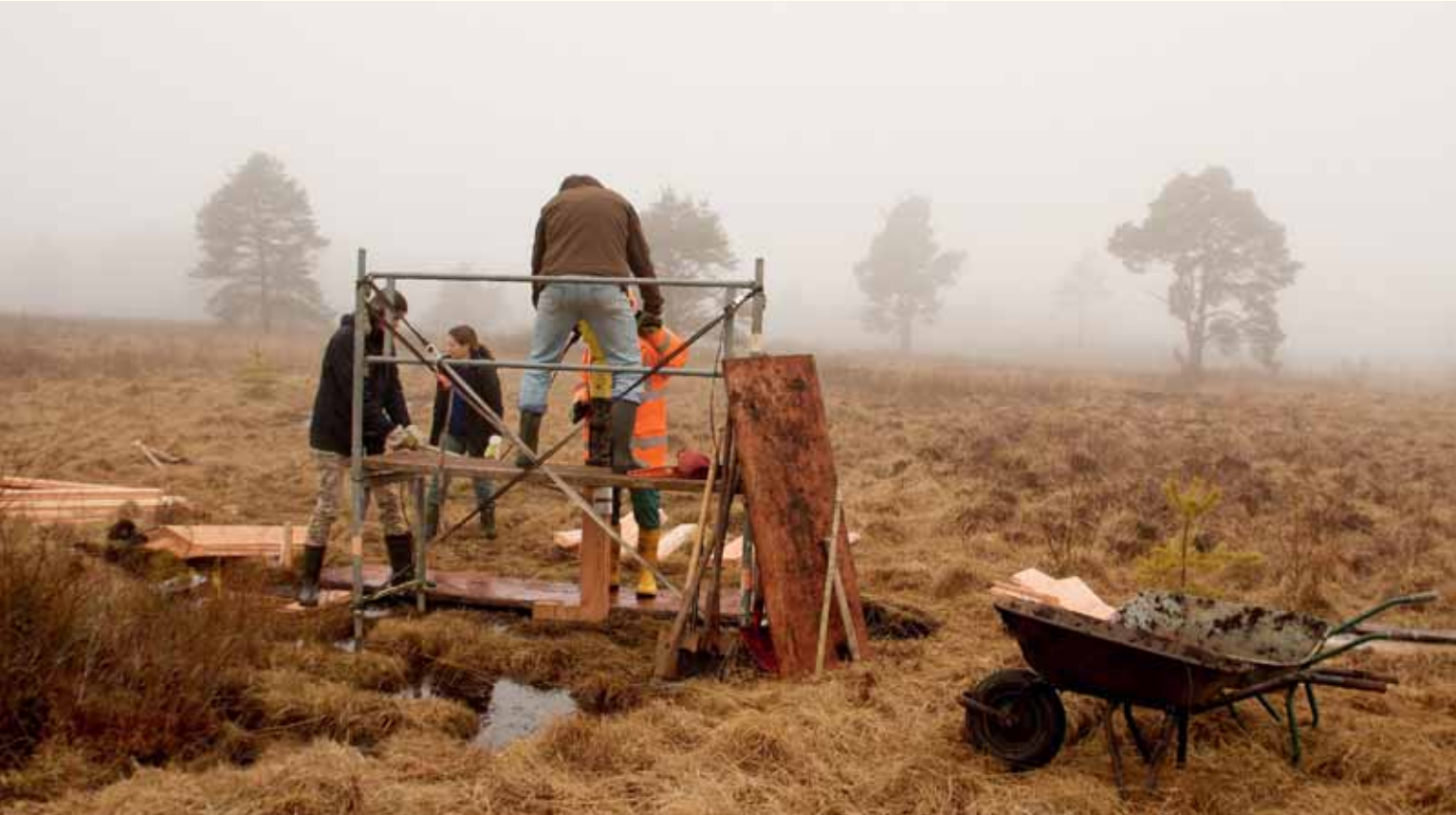
Im Schwenninger Moos war der BUND Schwarzwald-Baar-Heuberg e. V. mit dem Bau von Grabensperren aktiv. Diese Sperren tragen zur Wiedervernässung des entwässerten Moores bei.
