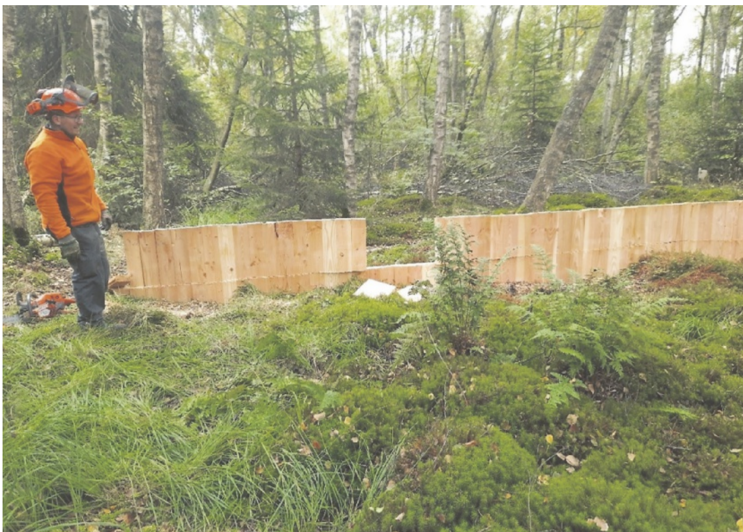
Sperrenbau im Schwenninger Moos während der Bauphase: Noch nicht überdeckte Holzpalisade auf Villinginger Gemarkung.
