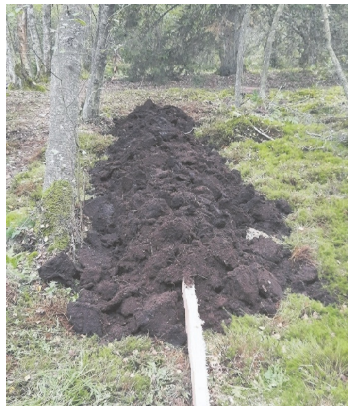
Die Wassersperren werden mit Torf überdeckt.
