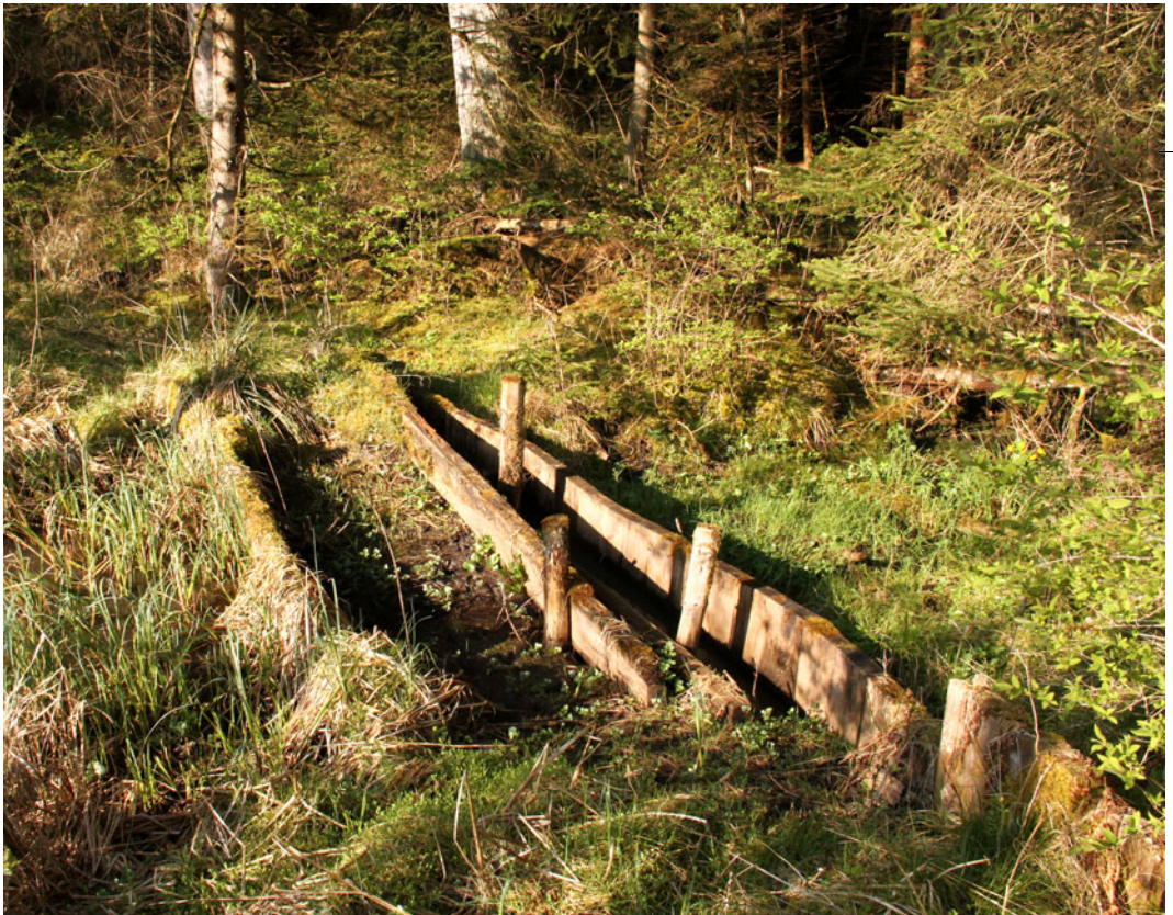
Beispiel einer Entwässerungssperre im Fördergebiet Plattenmoos.
